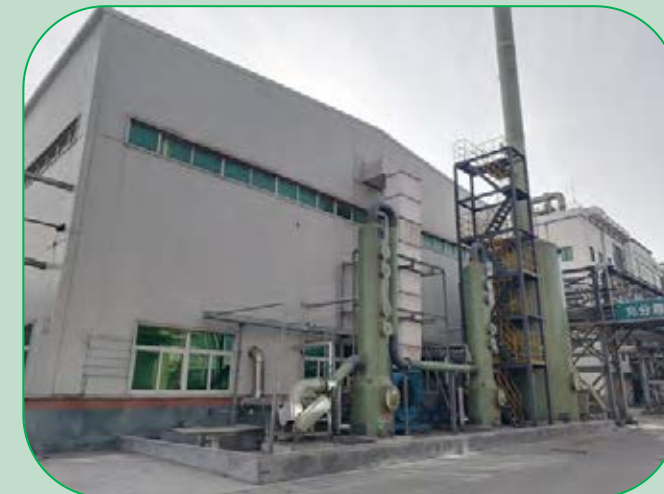
潍坊东厂区尾气吸收塔改造
