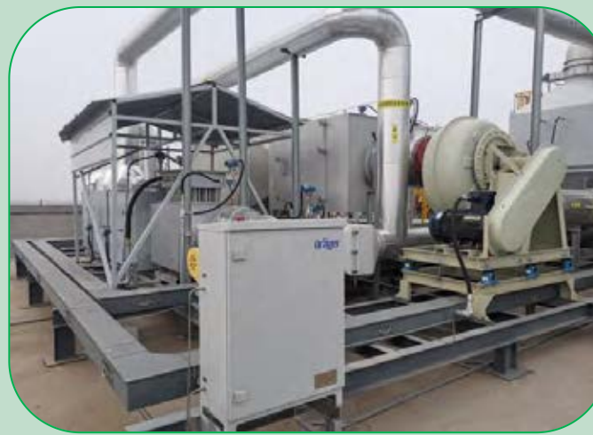
潍坊北厂区VOCs废气治理提升改造
