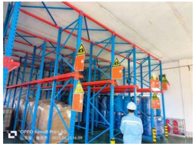
平度厂区危废库
