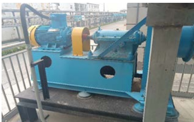
设备安装减震器
