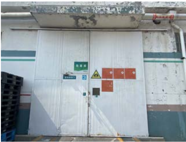
潍坊西厂区危废库
