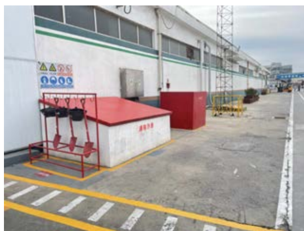
仓库外应急设施
