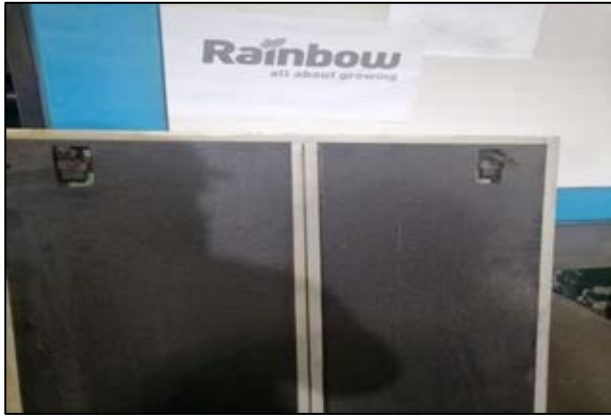
空压机内安装隔音棉
